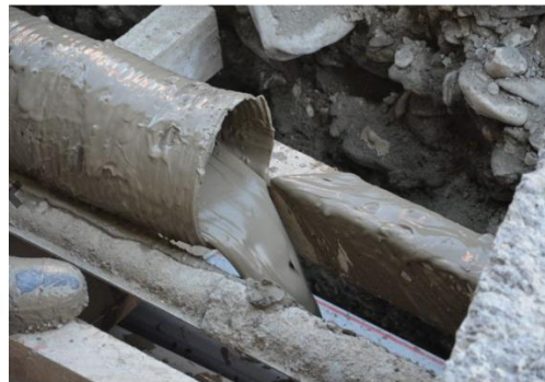
1.3.13 pav. Mobilus betono siurblys (kairėje) ir SSMG mišinio transportavimas iš maišymo mazgo į aikštelės užpildomas vietas (dešinėje).
