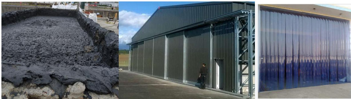
1.3.7 pav. Užteršto grunto talpa (kairėje), uždaros stoginės/uždangos pavyzdys (per vidurį), stumdomų PVC užuolaidų pavyzdys (dešinėje).
