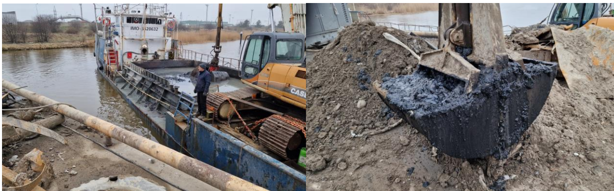
1.3.15 pav. Barža su iškastu gruntu (kairėje) ir iškastas grunto kaušas bandinių atrankai (dešinėje).
