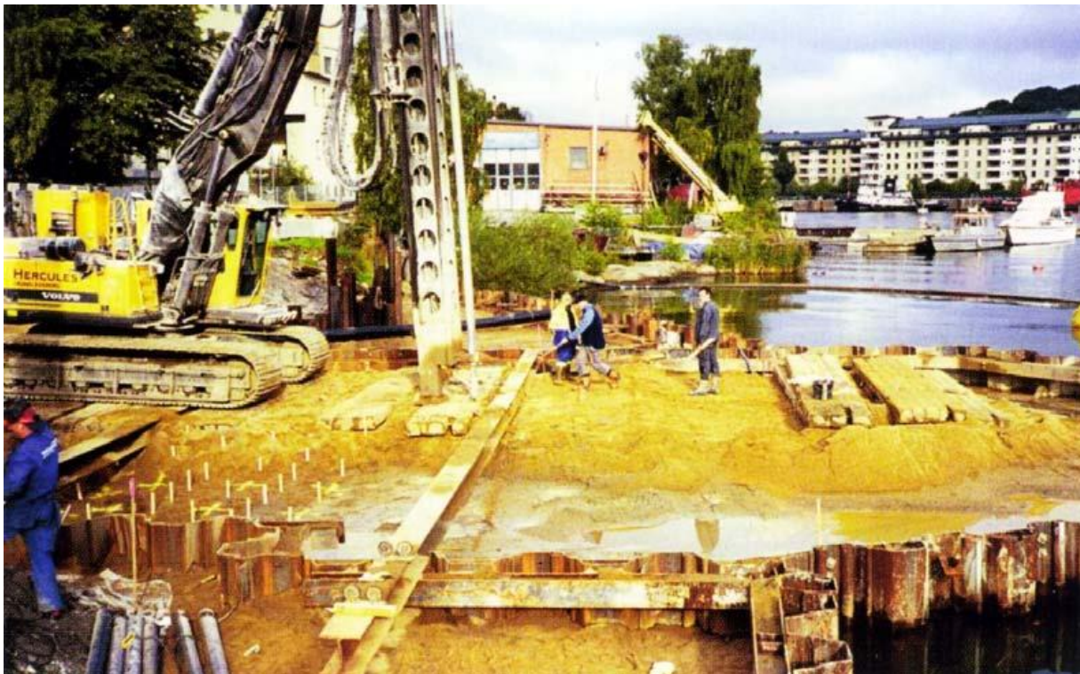
1.3.27 pav. Giluminis užterštų nuosėdų stabilizavimas Hammarby Sjöstad, fomuojant naujos krantinės pagrindą.
