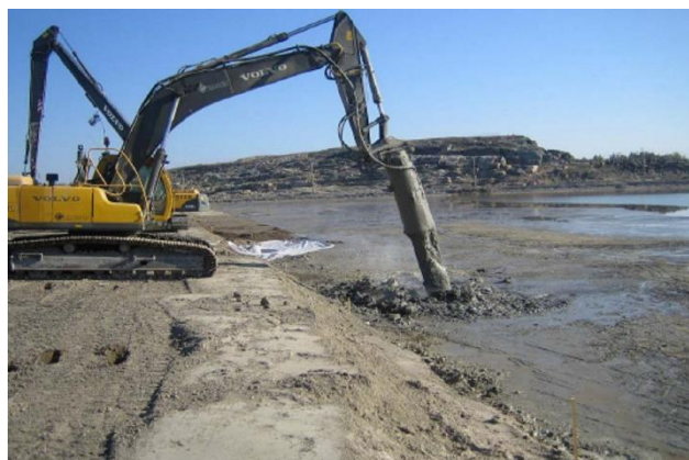
1.3.28 pav. Įrengtas testavimo baseinas bei atskirtos lagūnos grunto stabilizavimo darbams vykdyti (kairėje) ir TBA junginiais užteršto grunto stabilizavimo darbai lagūnoje A1 (dešinėje).
