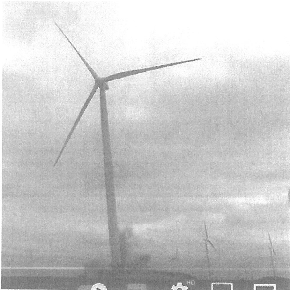
1 pav. Sprogdinamos atidirbusios vėjo elektrinės.
