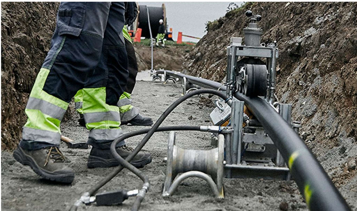
6.4.7 pav. Kabelio klojimas atviru būdu
